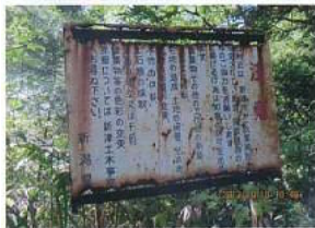
標示板の劣化
