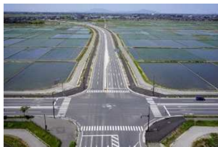
新潟中央環状道路 横越バイパス
