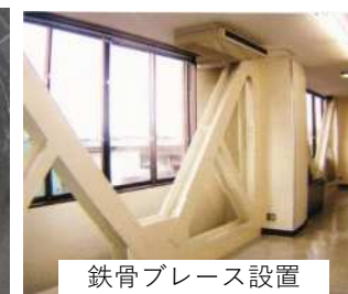
下水処理場の耐震化
