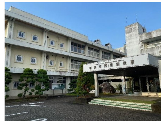
西蒲区役所庁舎外観
