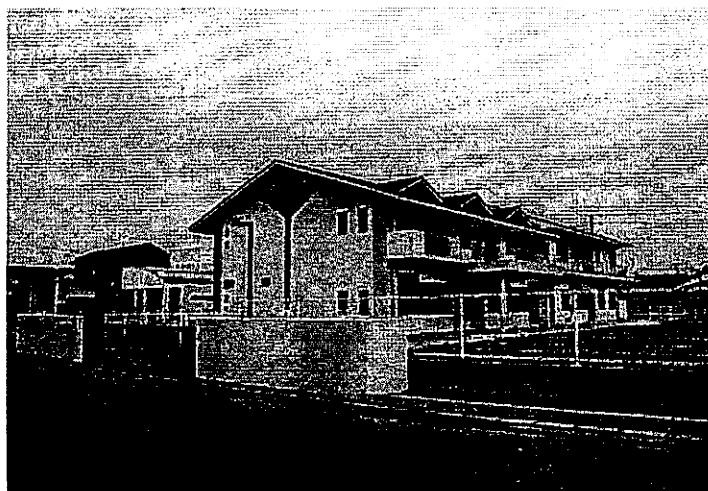
興野保育園(平成20年2月竣工)
