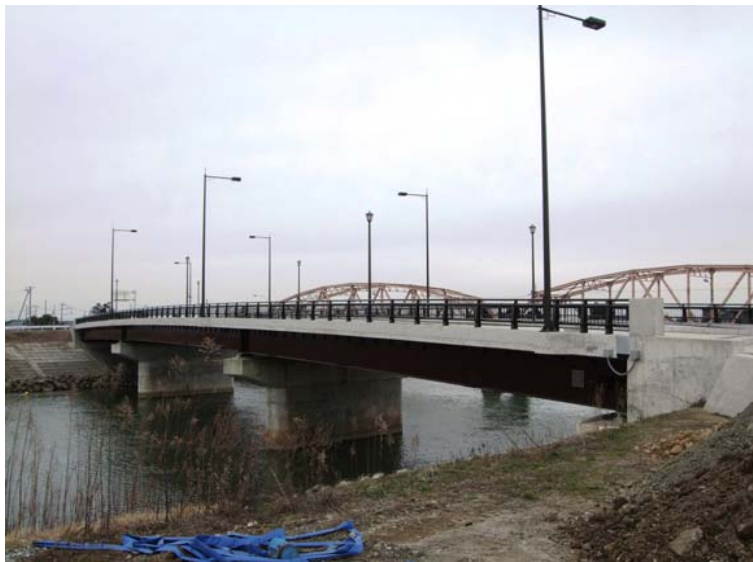
(主)長岡栃尾巻線 両郡橋
