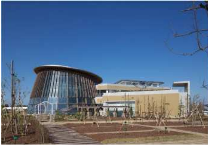
食育・花育センター(平成23年7月竣工)
