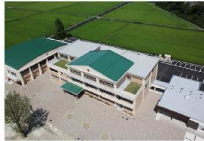
新関小学校(平成23年3月竣工)
