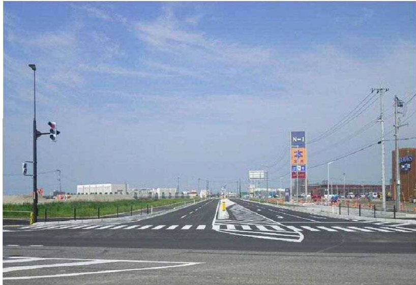
小新亀貝線(亀貝工区)
