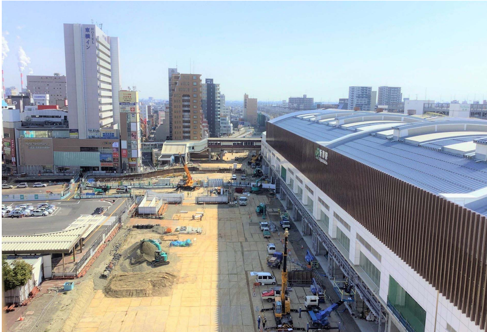
整備中の新潟駅万代広場（令和5年4月14日撮影）
