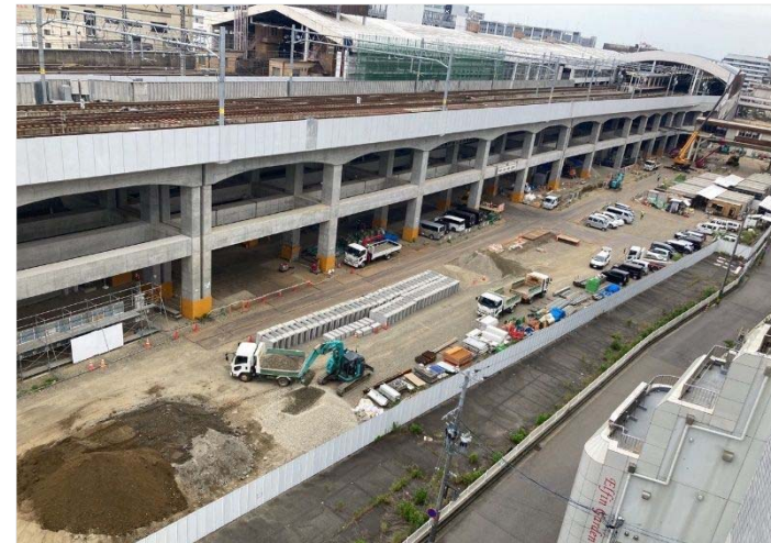
在来線高架化工事(仮線・仮ホーム撤去後)の状況
