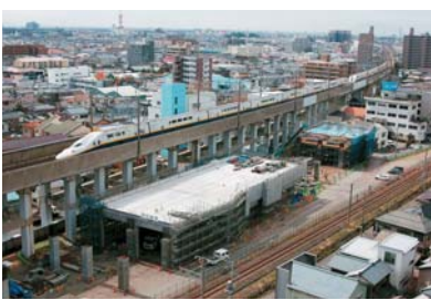
電車留置線の高架橋工事
