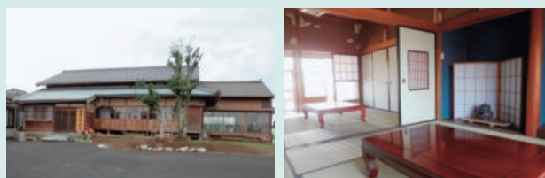
空き家を「地域の茶の間」に改修した例（北区横井）
