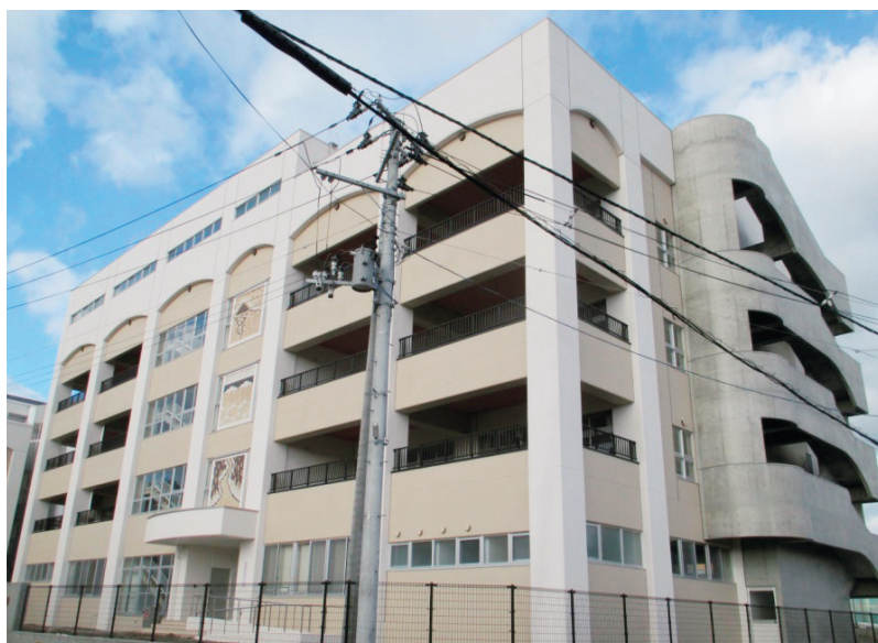
普通教室棟外観
