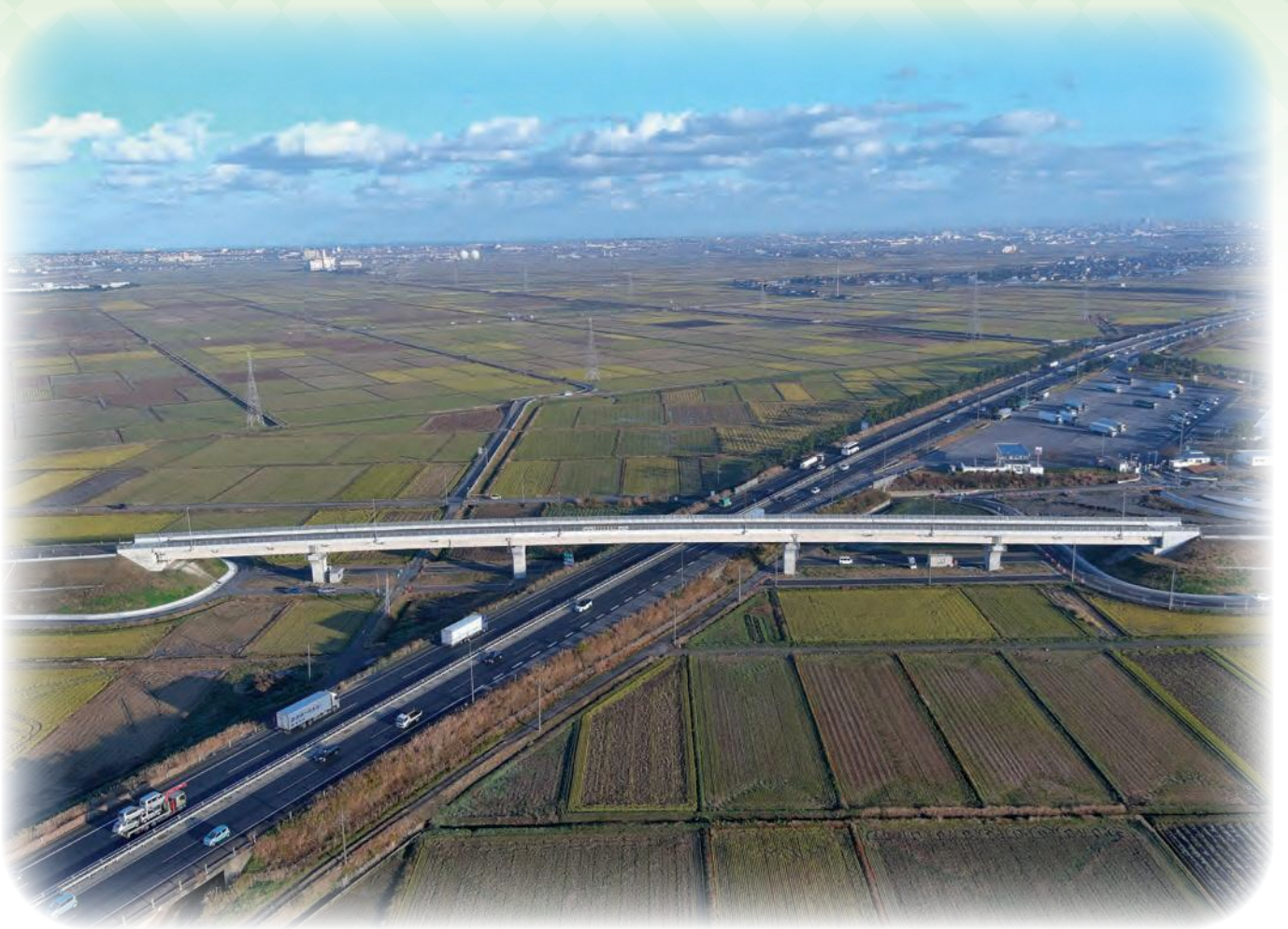
北陸自動車道に架かる主要地方道 新潟中央環状線「くろさき茶豆大橋」
