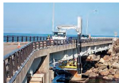
橋梁点検の状況
