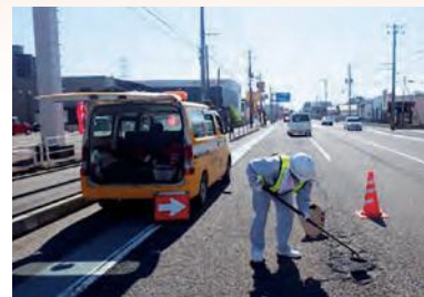
舗装補修の状況
