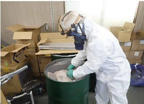
PCB汚染物保管状況
