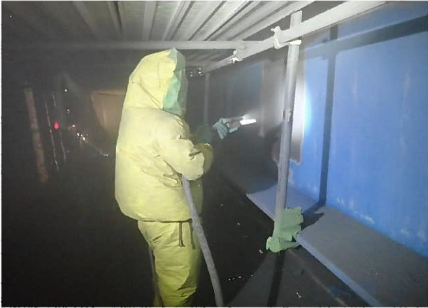
循環式ブラスト工法施工状況
