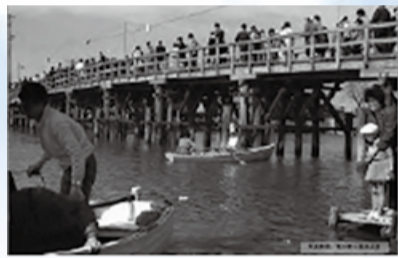
昭和37年頃の初代弁天橋 (写真提供 亀田郷土地改良区)
