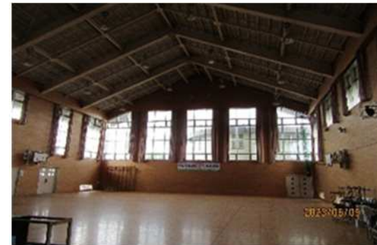
旧潟東西小学校体育館
