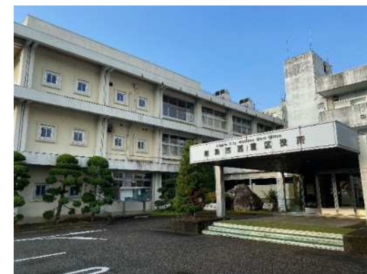
西蒲区役所庁舎外観
