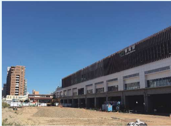
工事が進む新潟駅新万代広場
