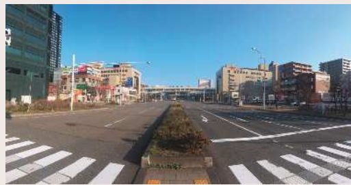
無電柱化された道路
