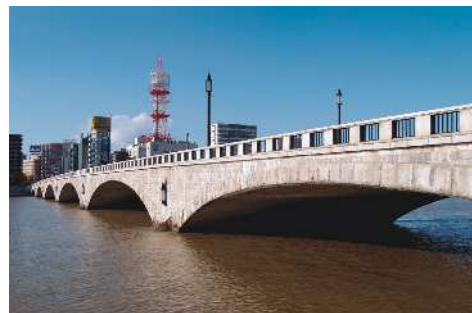
重要文化財萬代橋
