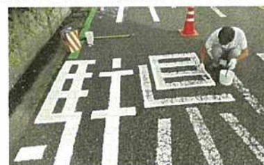
職員による道路標示補修
