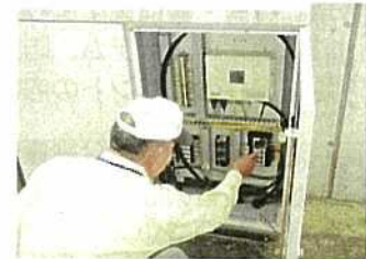
配電盤の点検
