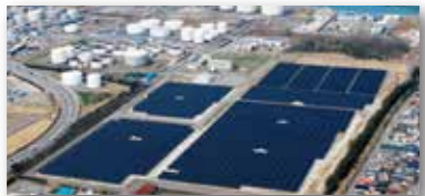
「新潟雪国型メガソーラー発電所」(2010) 「出光興産」HPより
