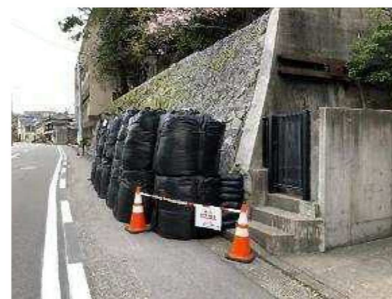
現在の擁壁の状況
