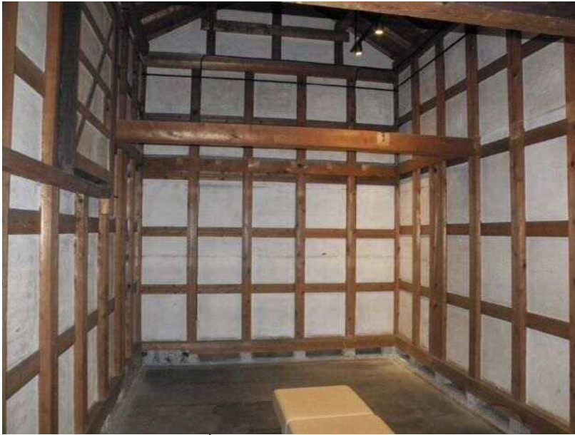
南土蔵 活用のために2階床を撤去
