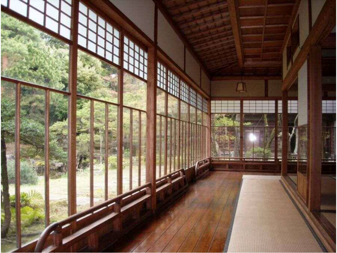
主屋 1 階北縁 東を見る
