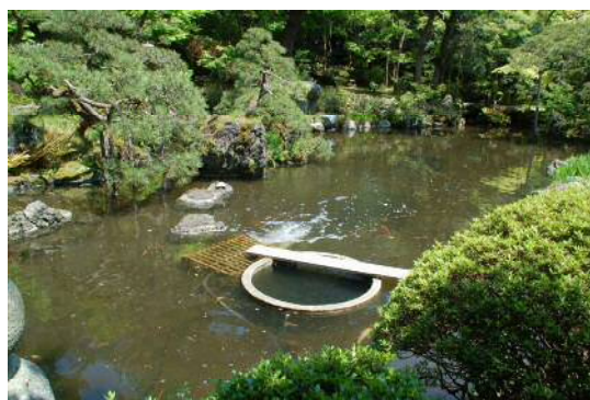
図 3-21 水面から露出したコンクリート
