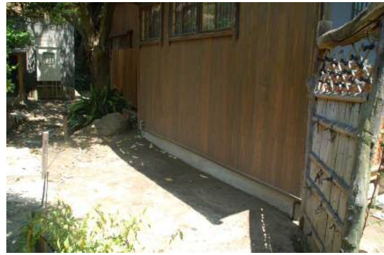
図 3-14 袖塀と配電盤
