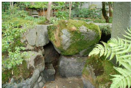
図 3-19 下部に亀裂の入った護岸飛石
