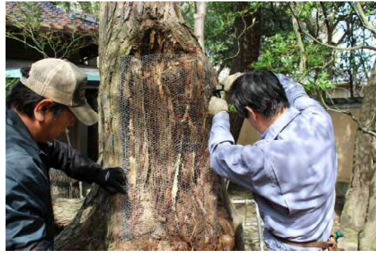
図3-35 メタルラスによる養生
