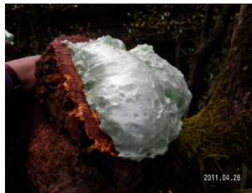
図3-41 防腐処理とウレタンの塗着
