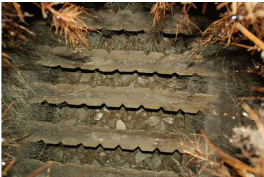
図3-57 D孔から見た内部構造
