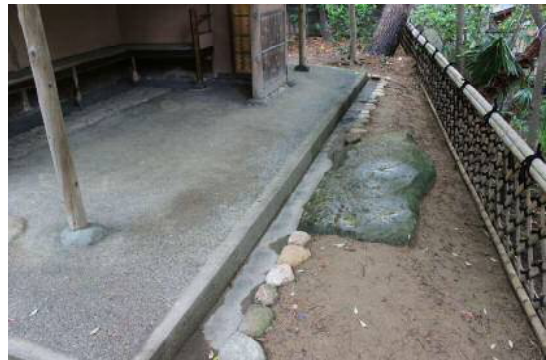
図3-33 待合の軒内（復旧後）
