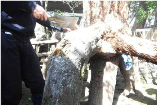
図3-34 既存のウレタン処理部の撤去
