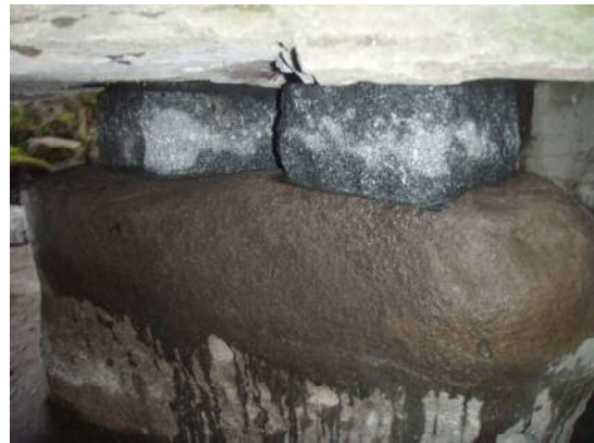
図3-30 東側石橋（調整後）
