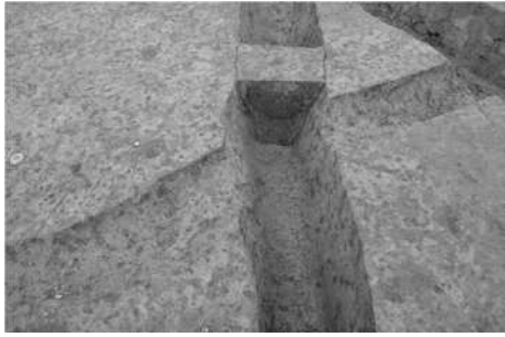
掘立柱建物跡(平安時代・SB4001)周溝
