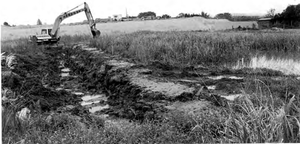
B・C区水抜き
