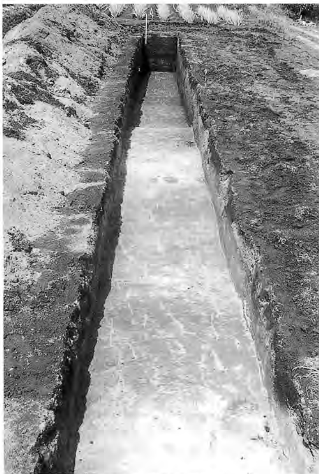
試掘坑 調査終了状況
