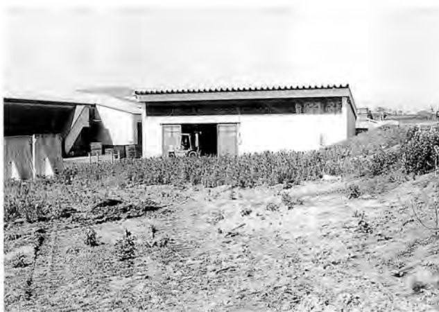
調査地全景 (北から)
