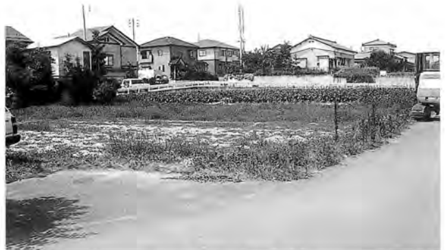
調査地全景 (北から)
