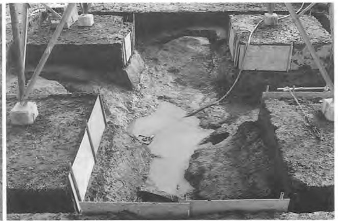
河完掘状況 (北→南)
