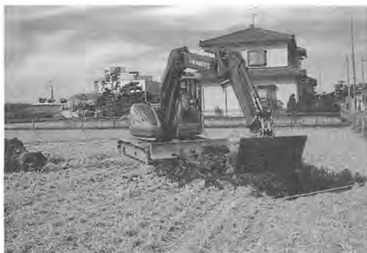
中谷内遺跡1区表土除去状況
