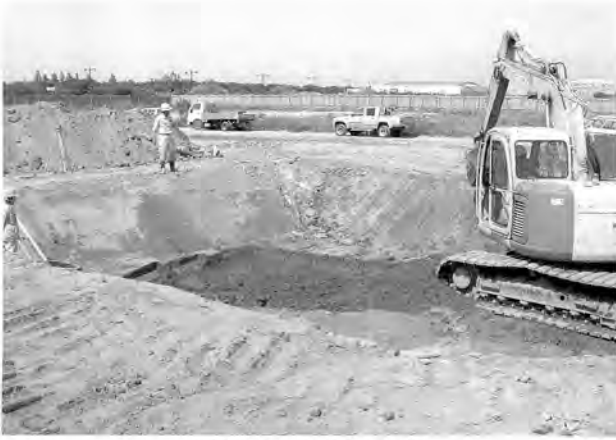
写真19 2T調査状況
