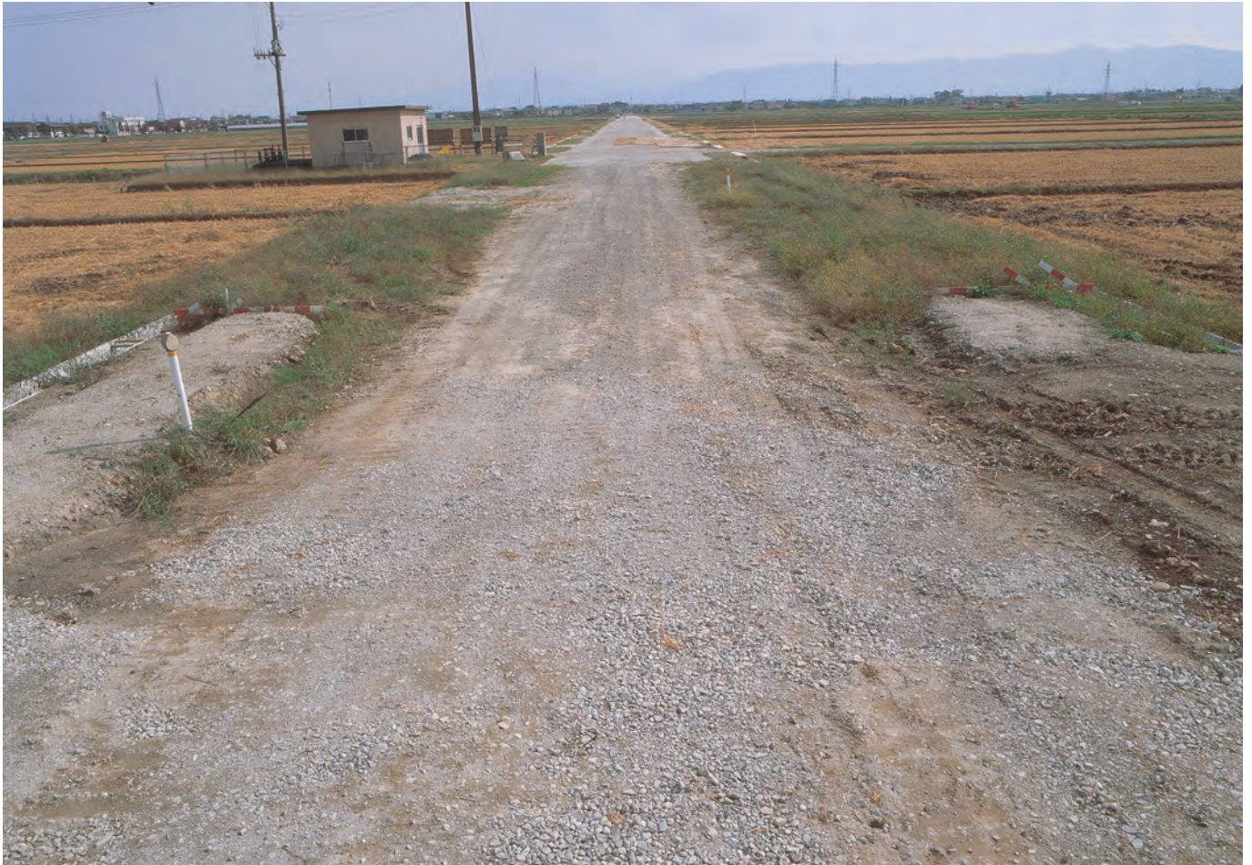
着手前 西から
