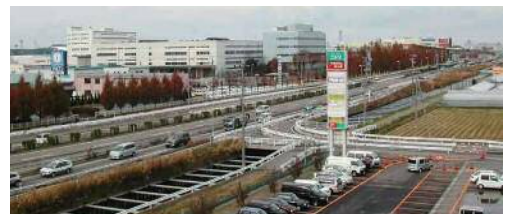
亀田バイパス沿いの排水路と左に見える工業団地
