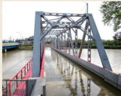
新川の上を通る西川水路橋
