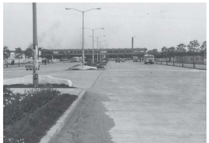
写真3 4代目駅舎 現在地に移転し、信越線・越後線・白新線が接続した。
