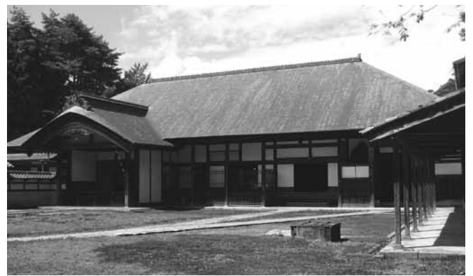
重要文化財 旧笹川家住宅
