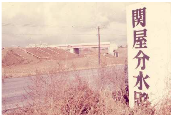
年不詳 関屋分水路工事（当館所蔵）
