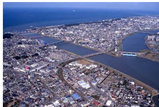
平成10年 関屋分水路（当館所蔵） 分水路の完成により、市街地は分水路と信濃川に囲まれ、「新潟島」と呼ばれるようになった。
