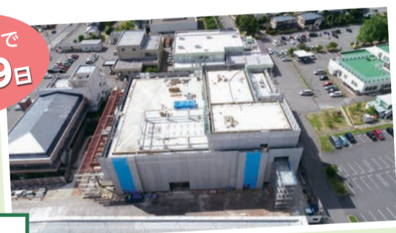
▲建設中の新庁舎(R2.6撮影)
