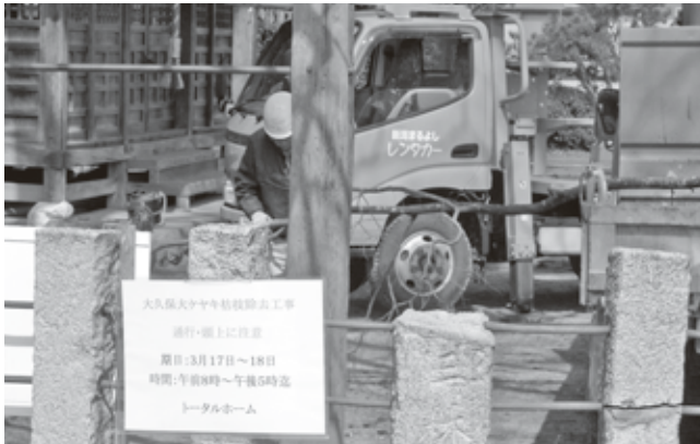
枯れ枝除去工事
