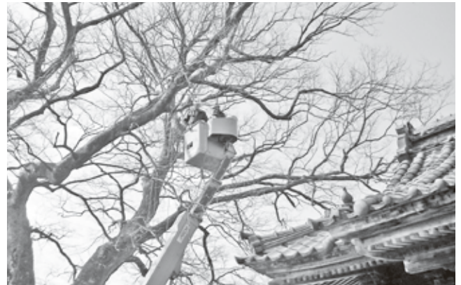
枯れ枝除去工事
