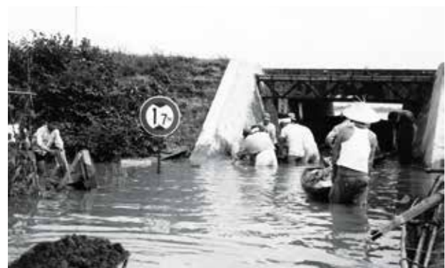
南側からの水で水没した白新線のガード下。土のうをキッソブネで運ぶ。 (昭和41(1966)年7月 新潟市北区新崎1丁目) 伊藤 昇 氏 撮影
