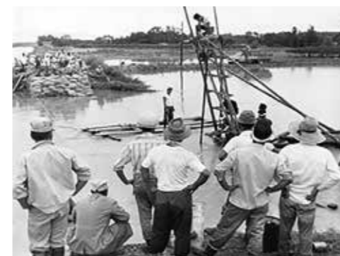
新発田川決壊箇所の仮復旧作業。(新潟市北区浦ノ入地内)
