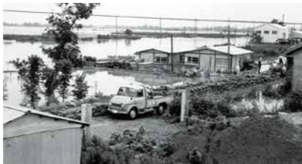
土のうが積まれた新井郷川の左岸。あふれた水を食い止める。(昭和41(1966)年7月 新潟市北区新崎3丁目) 伊藤昇氏 撮影
