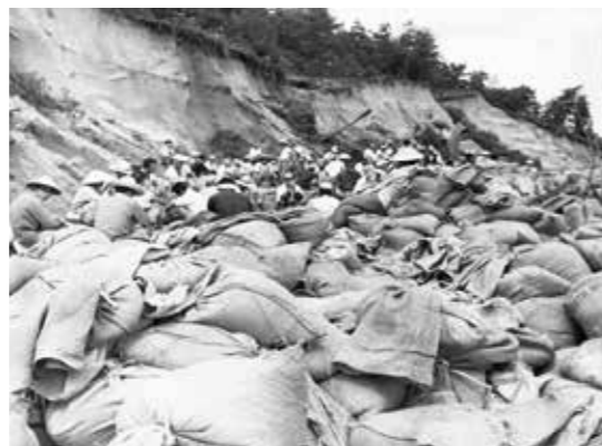
山を切りくずして土のうをつくる。(新潟市北区木崎地内)
