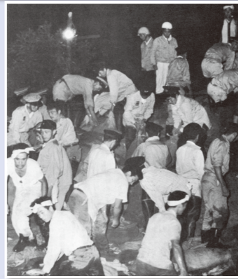
夜を徹して太田川決壊か所の締め切りを急ぐ
