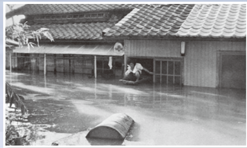
町でいちばん大きな家屋被害をうけた前新田沖
