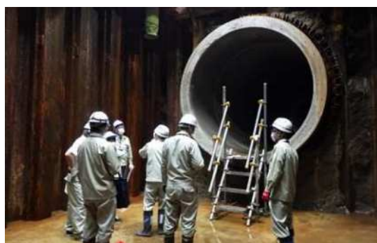
雨水貯留施設の整備
