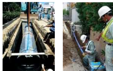
耐震管への更新工事
