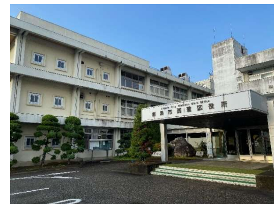
西蒲区役所庁舎外観
