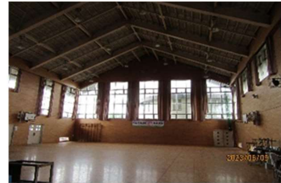
旧潟東西小学校体育館
