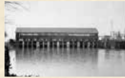
栗ノ木排水機場
