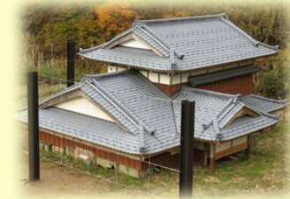
水没した家屋(下半分が土砂で埋まっている)
