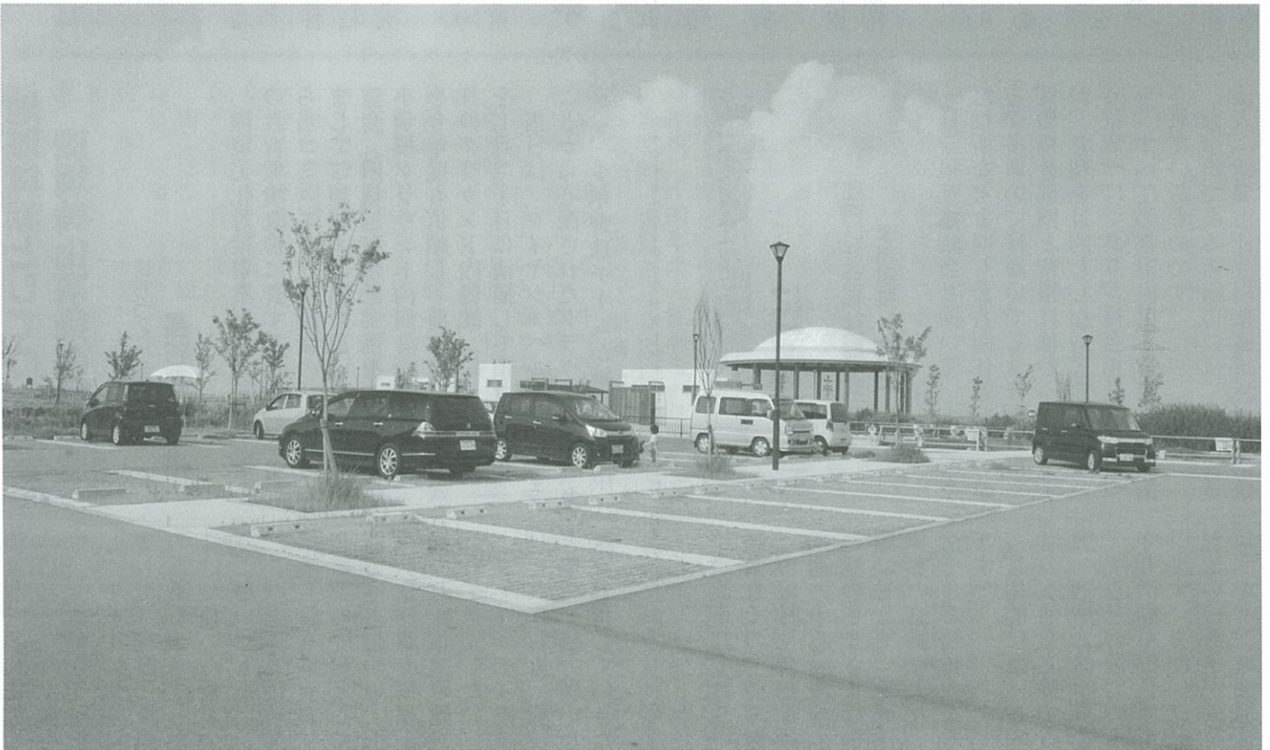
完成まじかのよこごし公園（一部供用）
