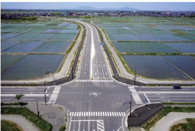
新潟中央環状道路 横越バイパス
