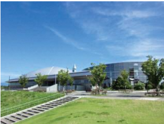
亀田総合体育館
