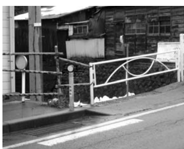
改修前の歩道
