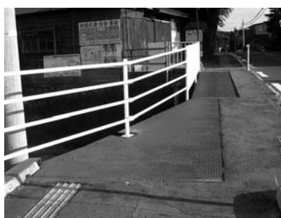
すっかり危険も解消された
