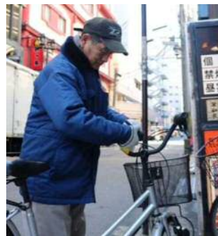
撤去作業の状況
