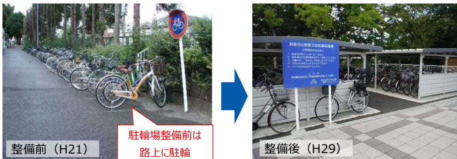
越後石山駅駐輪場の整備前後の状況
