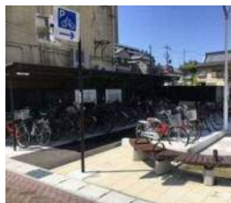
西堀通6番町駐輪場
