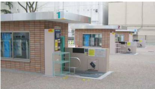
⑦公園地下を活用した機械式駐輪場
