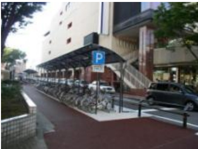
④道路上の空き空間を活用した駐輪場（新潟市）
