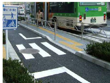
写真Ⅱ-5 停止線を設置した事例
