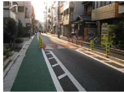
写真Ⅱ-13 車道部分にハンプを設置しハンプの両側にゴム製ポールを設置した事例
