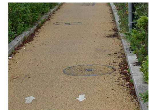
写真Ⅱ-3 マンホールの蓋に滑り止め加工している事例
