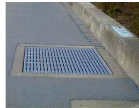
写真Ⅱ-2 グレーチング蓋の格子間隔を狭め、滑り止め加工している事例
