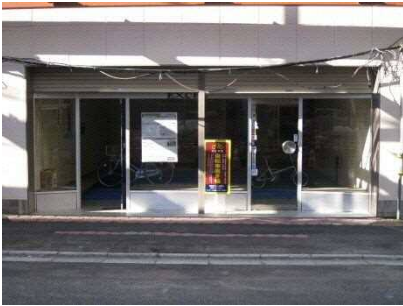
①商店街の空き店舗を活用した駐輪場（新潟市）
